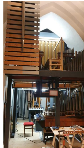
Die neue Orgel im Bau im Juli 2021
