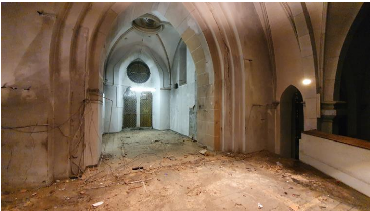
Bauzustand nach dem Abbau der alten Orgel
